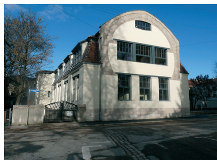
Südgiebel des Van-de-Velde-Gebäudes nach der Sanierung Quelle: Architekturbüro Junk und Reich, Foto: Th. Rämmler
