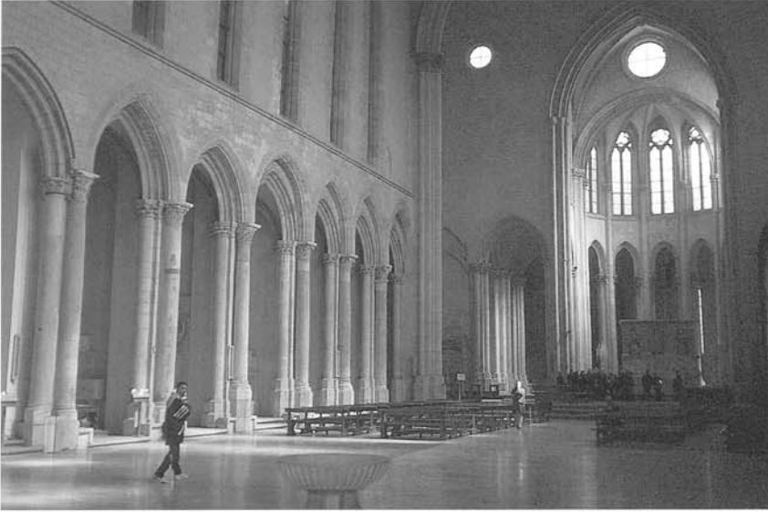
Abb. 4 Neapel, San Lorenzo, Wandaufriss mit den vorgestellten Spoliensäulen vom Vorgängerbau.
