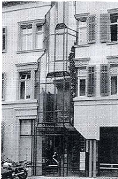
Abb. 2: Nordstraße 9, Zürich. Umbau eines Mehrfamilienhauses in ein Bürohaus mit betont dramatischer Gebärde.
